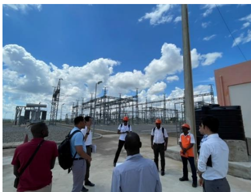
ナミアロ変電所視察
