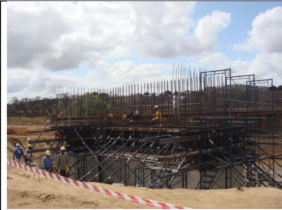
Situação da obra da Ponte de Mutabashi
