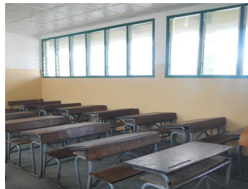
新設された教室の内装
